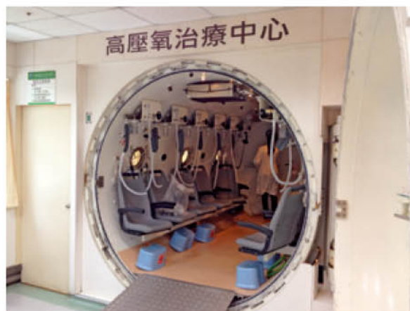
高壓氧多人艙，能處理緊急重症病患。可有陪艙護士陪同，並能治療有使用呼吸器的病人。
